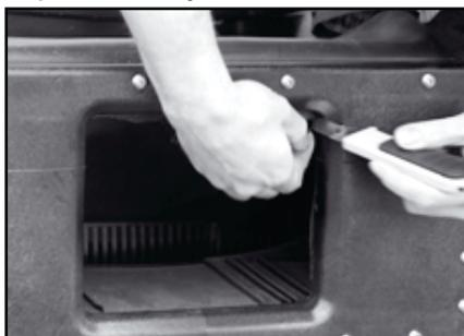
После того, как передняя крышка надежно и должным образом установлена, Вам следует обрезать плёнку с помощью ножа с внутренней стороны скиммера.
