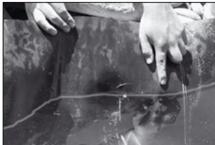
Измерьте уровень воды Вашего садового пруда в тот момент, когда он заполнен полностью, а именно, на уровне прокладки в месте размещения скиммера. Частично спустите пруд на 20 - 25 см перед началом процесса установки скиммера.
