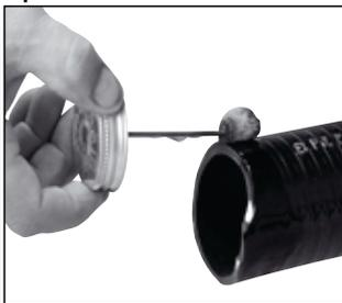
Примените грунтровку для внутренней части колена 90 градусов и для внешней части шланга ПВХ. Повторите этот процесс с использованием специального клея ПВХ.
